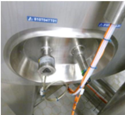
Über 60 Temperatursensoren der Serie TFP sorgen in den gesamten Prozessschritten für eine präzise Überwachung aller für die Qualitätssicherung vorgegebenen Temperaturen (Foto: Anderson-Negele)
