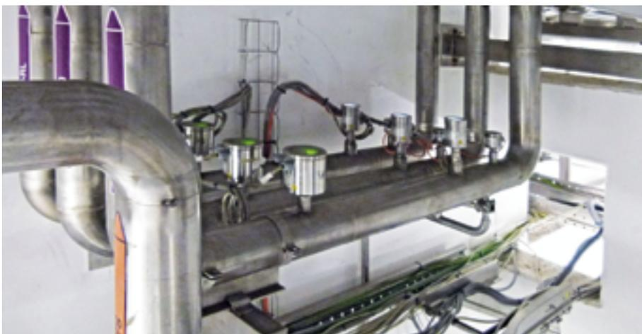
Eine permanente Überwachung aller Produktionsschritte sowie der entsprechenden CIP-Reinigungsprozesse erfolgt über hygienische Sensoren von Anderson-Negele (Foto: Anderson-Negele)
