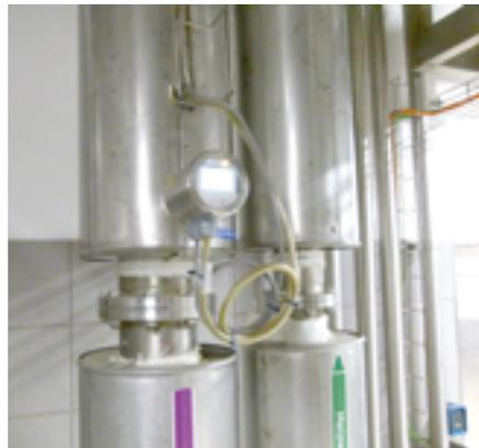
Bei der CIP-Reinigung helfen in Viöl Leitfähigkeitsmessgeräte vom Typ ILM für eine präzise Phasentrennung bzw. eine bedarfsgerechte Aufschärfung der Säure-/Laugekonzentration (Foto: Anderson-Negele)
