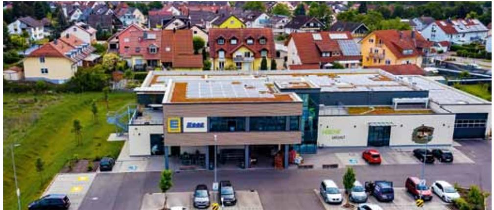
**Auf einer Gesamtfläche von knapp 900 Quadratmetern wurden insgesamt 452 Module und vier Wechselrichter verbaut. Die Leistung der Anlage ist auf rund 122 Kilowatt Peak ausgelegt. Eine sechsstellige Summe wurde investiert.**
