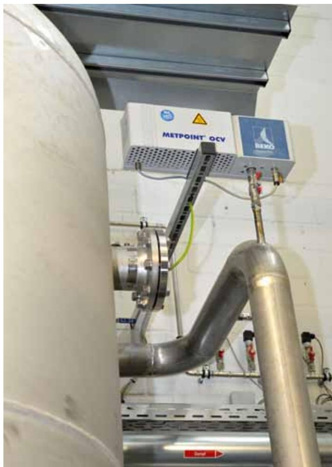
Mit solchen Systemen kann der Restöldampfgehalt in Druckluft 24/7/365 überwacht werden
