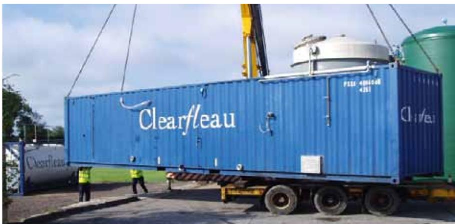
Die Biogasanlagen werden in Containerbauweise hergestellt (Foto: Clearfleau)
