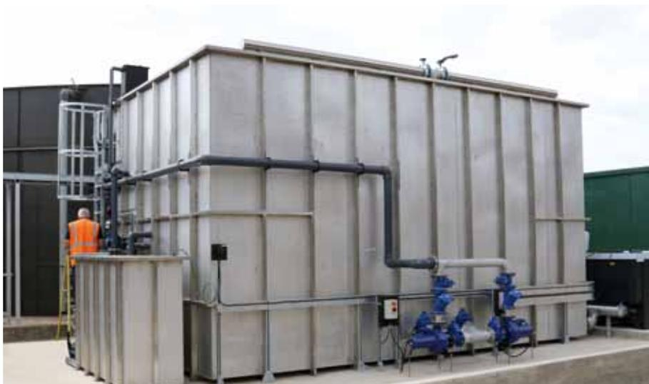
Aerobe SBR Anlage zur industriellen Abwasserklärung (Foto: Clearfleau)
