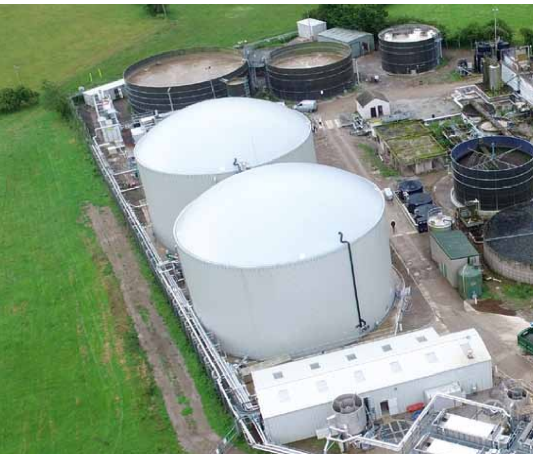
Biogasanlage mit direkter Einspeisung ins Netz, installiert in der Lake District Creamery
