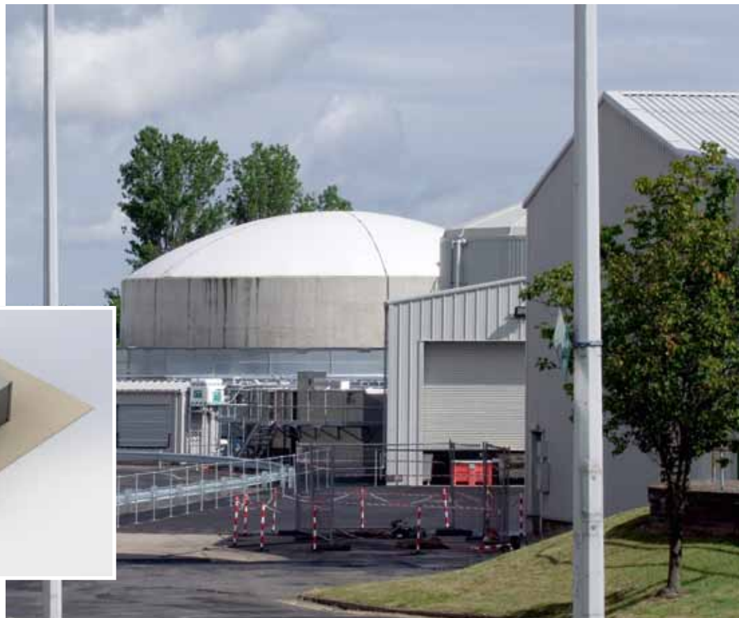
Biogenergie-Anlage im Nestlé-Werk in Newcastle
