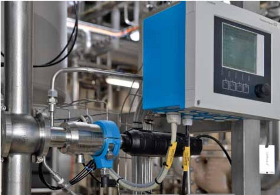
**Inline-pH-Messung mit dem glasfreien IsFet-Sensor CPA471D. Dank der Wechsellagerung CPA875 kann der Sensor auch während des Prozesses gereinigt und kalibriert werden**
