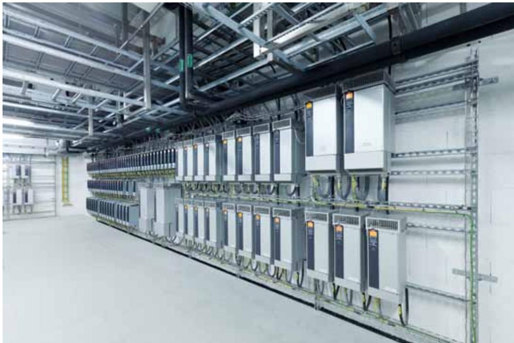
Bei der Milei 2.0 kommen in allen Arbeitsschritten drehzahlgeregelte Pumpen und Antriebe zum Einsatz (Foto: Danfoss/Birgitt Schlauderer)
