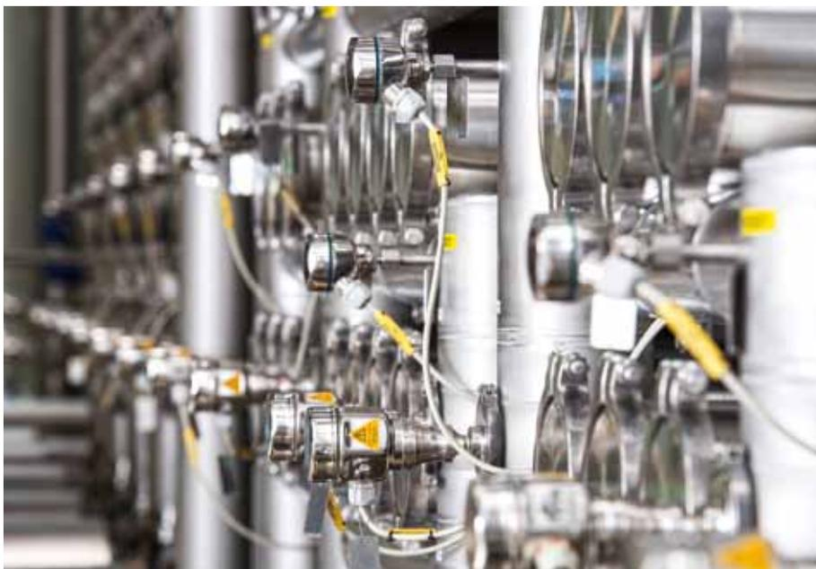
**Membranfiltrationsprozesse spielen die Hauptrolle bei der Fraktionierung von Milch und Molke: Druck und Temperatur überwachen Cerabar PMP55 und iTherm 411**
