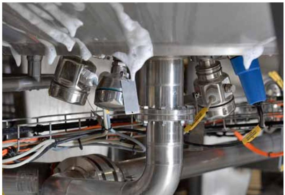
**Die Standard-Instrumentierung für Grenz-/Füllstand, Temperatur und Leitfähigkeit an den Tanks muss auch gegen Einflüsse der Außenreinigung beständig sein**
