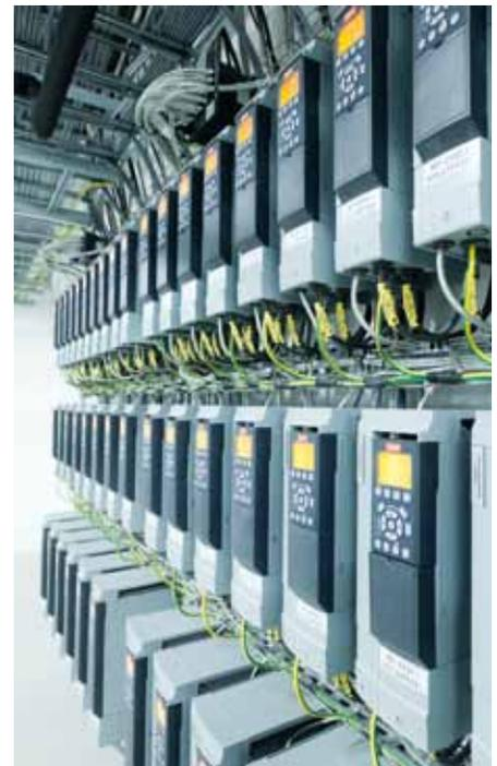
**Milei 2.0 setzt 1.000 Frequenzumrichter mit einer Gesamtleistung von über 4,5 MW ein, die Kabelwege betragen insgesamt 450 km (Foto: Danfoss/Birgitt Schlauderer)**
