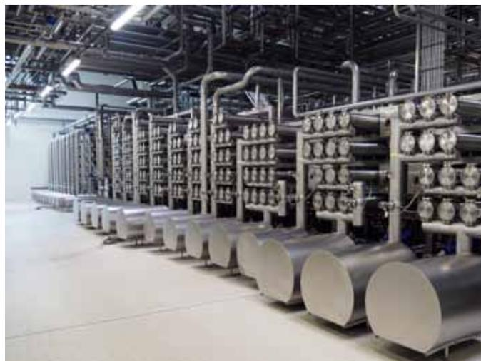
Im Neubau der Milei sind fast 90.000 m<sup>2</sup> Membranfläche installiert (Foto: mi)
