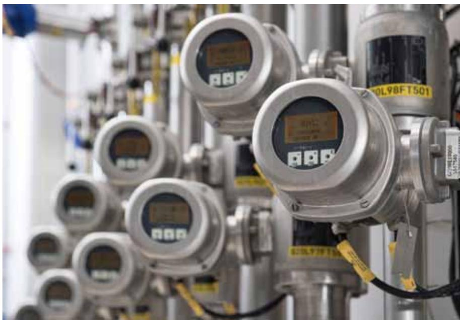
Die Fließgeschwindigkeiten im CIP-Prozess misst der Promag 53H
