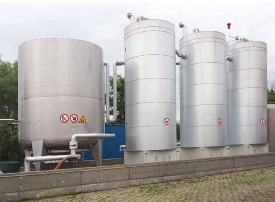
Die Biogasanlage bei Monte Ziego besteht tankseitig aus zwei Fermentern, einem Nachgärtank und einem Gärrestbehälter (Foto: mi)
