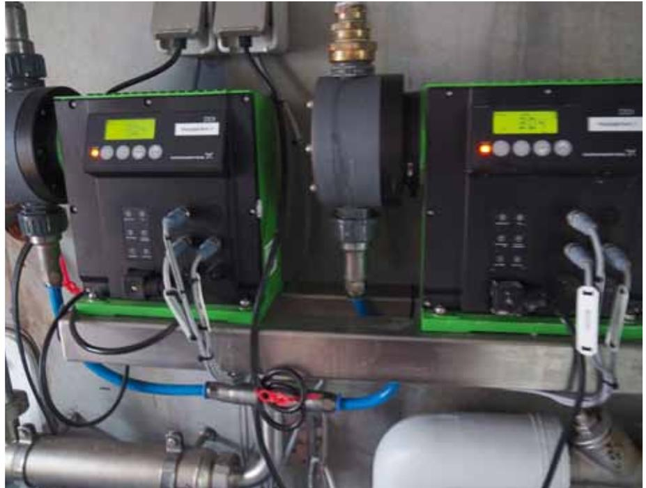
**Die Sauermolke wird, gesteuert über den pH-Wert, jeweils über eine Dosierpumpe in die Fermenter gefördert (Foto: mi)**
