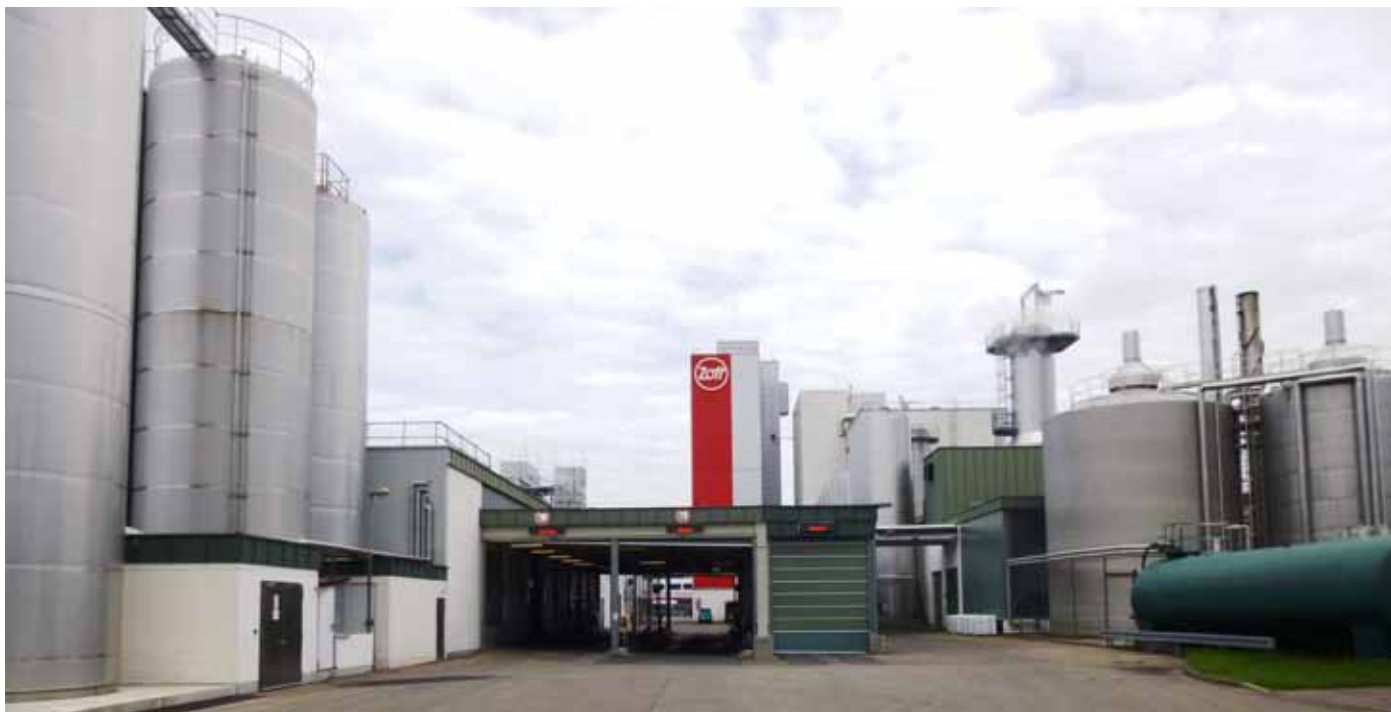
In der Günzburger Käserei von Zott wurde ein Teil des Werksbodens in kürzester Zeit grunderneuert (Foto: Sika)
