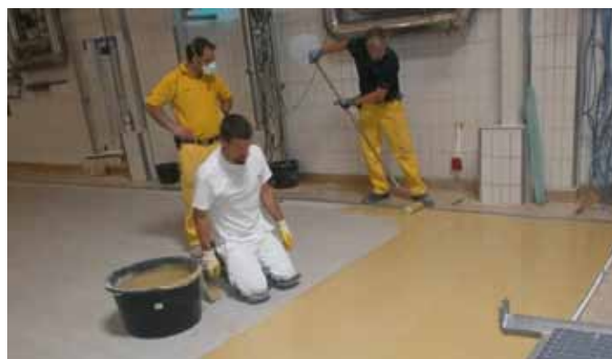
Den Abschluss am dritten Tag bildete die Applikation des 3-komponentigen polyurethanvergüteten Estrichs Sika floor-20 PurCem (Foto: Sika)
