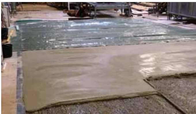
Am ersten Arbeitstag baute das Expertenteam mit Fräs- und Stemmarbeiten den alten Fliesenbelag bis auf den Grundbeton aus (Foto: Sika)
