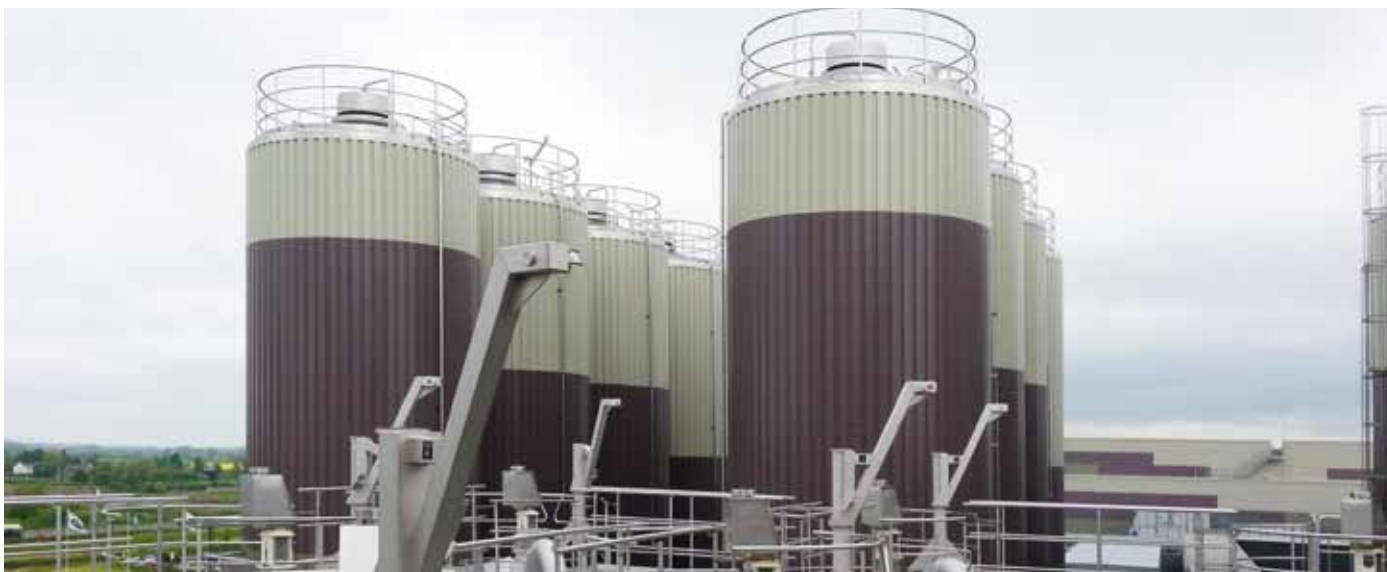
Die sterilen Tanks mit aseptischem Design von ZIEMANN HOLVRIEKA ermöglichen keimfreie Herstellung, Lagerung und Transport von Molkereiprodukten (Foto: ZIEMANN HOLVRIEKA)
