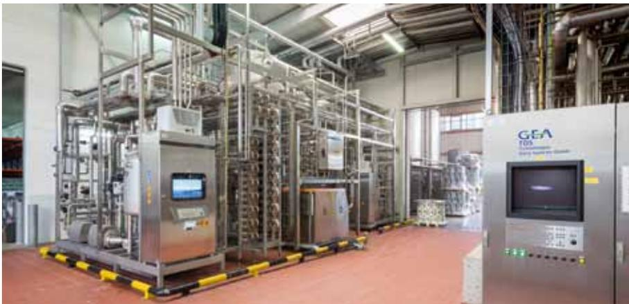
Die neue GEA-Infusionsanlage für die ESL-Milchproduktion wurde an das Automatisierungssystem Tetra Pak PlantMaster angebunden (Foto: Hohenloher Molkerei)
