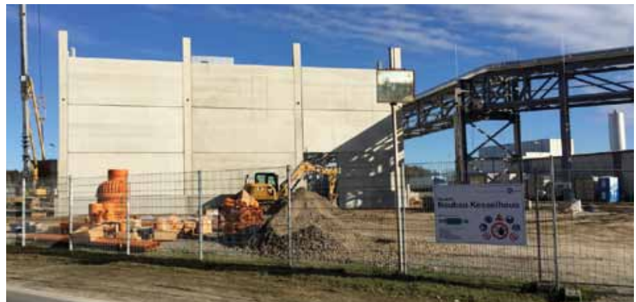
DMK baut in Zeven ein neues Kesselhaus (Foto: Rogge)
