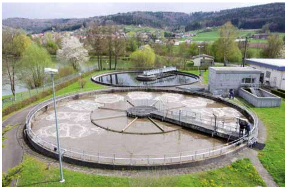
Mit Liquiline Control lässt sich die Belüftung in der Biologiestufe von Kläranlagen effizient regeln (Foto: Endress+Hauser)
