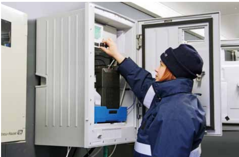
Instrumente wie der Online-Analysator für Ammonium Liquiline System CA80AM liefern die Messwerte zur Automatisierung der Anlage (Foto: Endress+Hauser)
