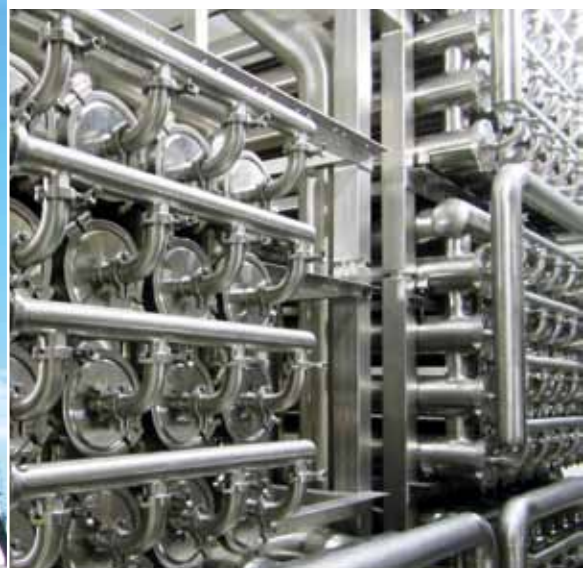
Die Sachsenmilch hat in Leppersdorf eine der größten Membranfiltrationsanlagen weltweit installiert (Foto: UTM)
