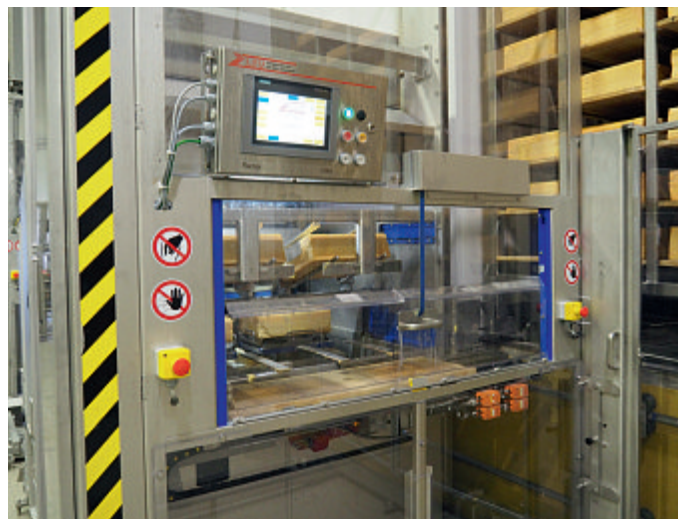
Die Käse werden von zwei fest stationierten Pflegerobotern behandelt (Foto: mi)
