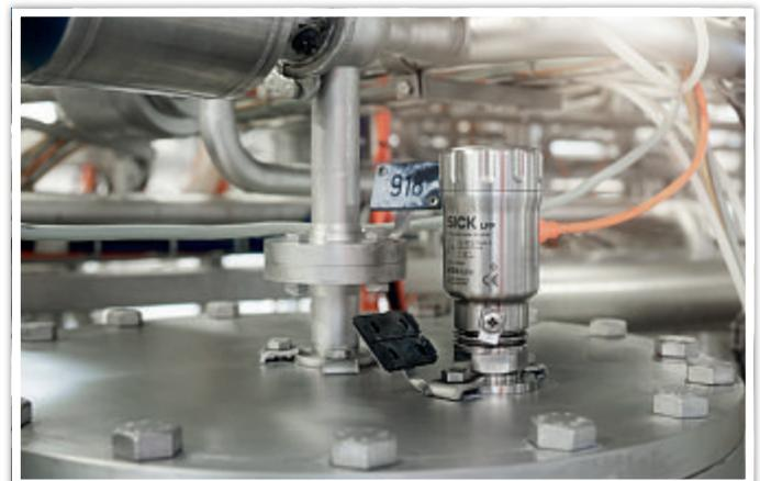
**Glänzende Aussichten für die Füllstandmessung in Molkereien: der LFP (Foto: SICK)**
