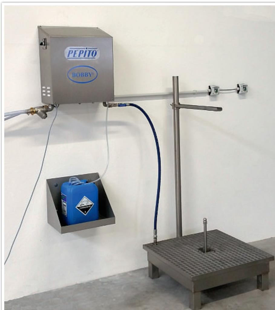
Die Kleingebindereinigungsstation Typ ND-BFR arbeitet im anwendersicheren Niederdruckbereich (Foto: Bobby)
