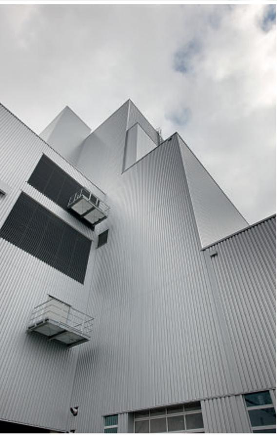
**Am DMK-Standort Zeven werden täglich etwa 3,2 Millionen Kilogramm Milch zu Pulver oder anderen Produkten verarbeitet. Im Zentrum der Milchtrocknungsanlage steht der rund 50 Meter hohe Sprühturm (Foto: Siemens)**
