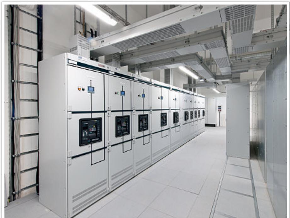
Um Störungen von Einzelkomponenten schnell und reibungslos beheben zu können, hat man bei DMK von Anfang an auf SIVACON S8-Schaltanlagen mit Einschubtechnik gesetzt. Außerdem im Bild: Stromschienenzu- und -abgänge (Foto: Siemens)
