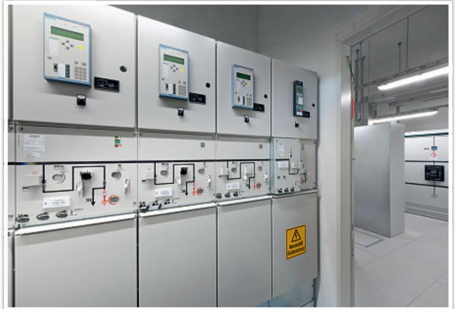
**Von der Übergabestation führen zwei eigenständige Versorgungswege zu zwei durch eine Feuerschutzwand getrennte Mittelspannungsanlagen vom Typ 8DJH (Foto: Siemens)**
