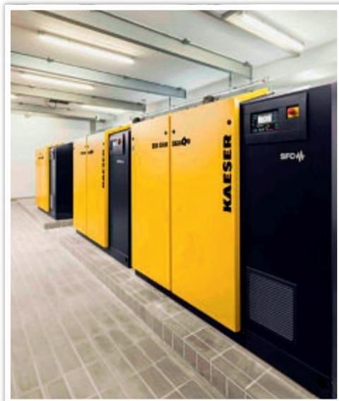
Die neuen Schraubengebläse von Kaeser Kompressoren mit Sigma Profil bieten höchste Energieeffizienz. Sie können bis zu 35 Prozent effektiver sein, als Drehkolben-gebläse (Foto: Kaeser)
