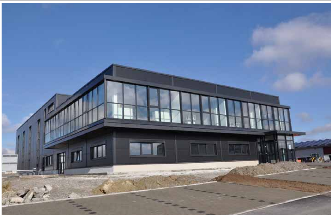
Das brandneue Gebäude der VMS-Maschinenbau GmbH bietet 1.600 m 2 Montage- und 400 m 2 Bürofläche (Foto: VMS)
