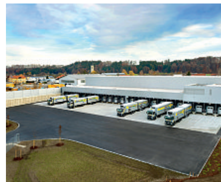
Bereits seit November 2015 im Einsatz: das neu errichtete Frischelager für Molkereiprodukte sowie Obst und Gemüse in Trostberg.
