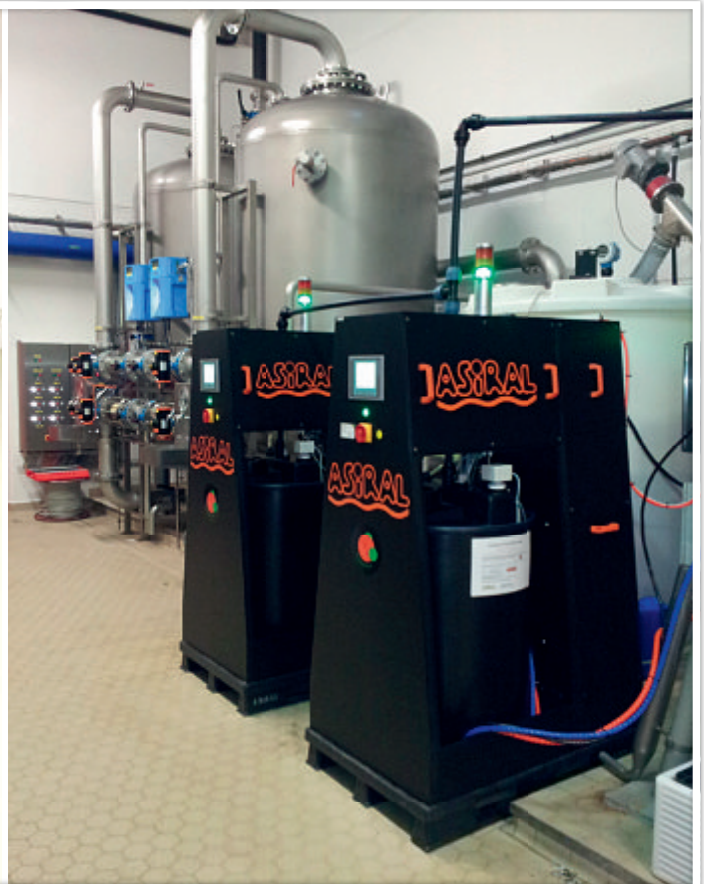
Abbildung 5: ASiRAL DS Pure Chlordioxidanlage in der Trinkwasseraufbereitung in der Molkerei (DMK Standort Altentreptow)
