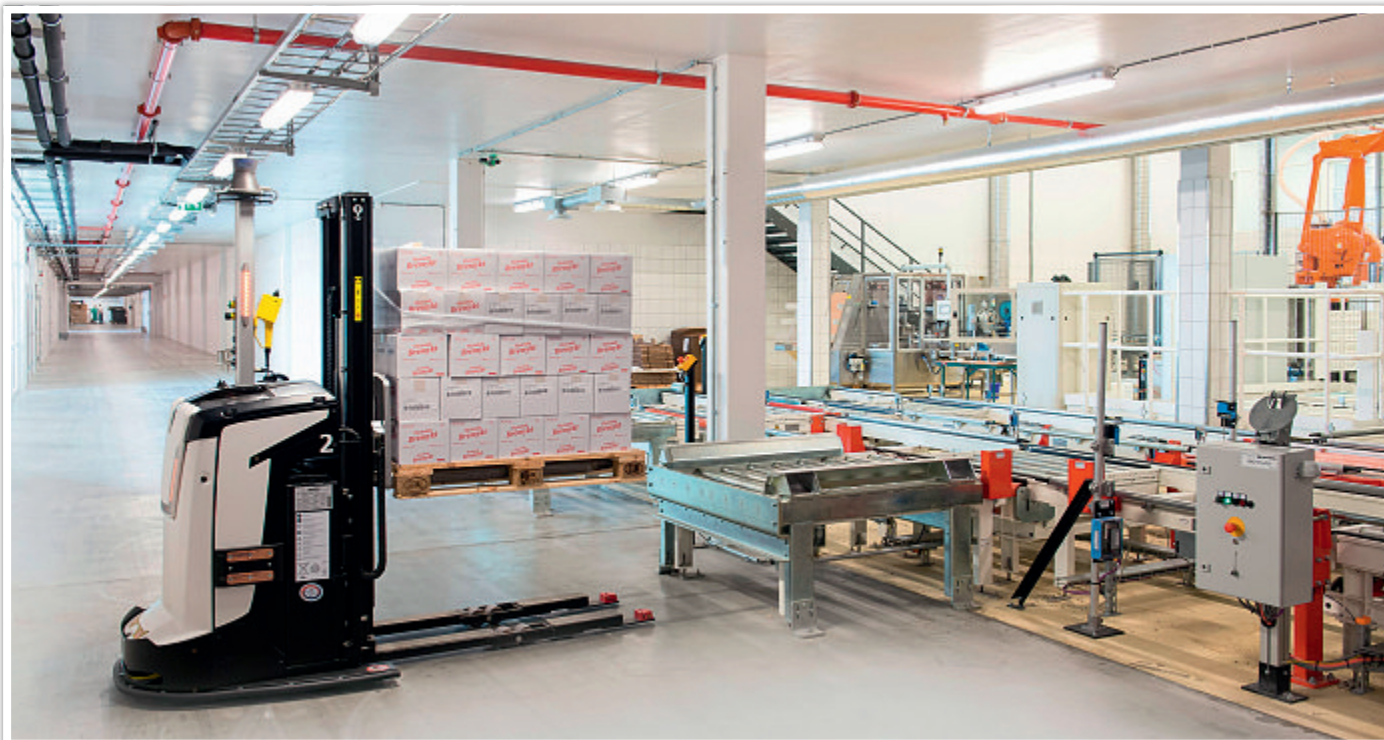
Fahrerlose Transportsysteme befördern die Einlagerungspaletten aus dem angrenzenden Produktionsgebäude in das Logistikzentrum (Foto: SSI Schäfer)
