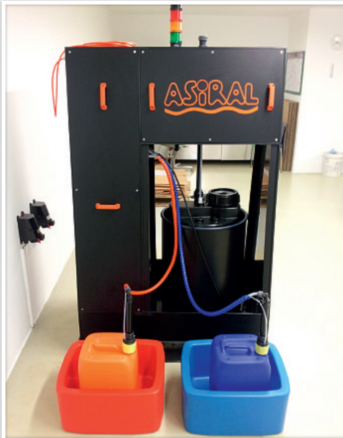
Abbildung 5: ASiRAL DS Pure Chlordioxidanlage in der Trinkwasseraufbereitung in der Molkerei (DMK Standort Altentreptow)
