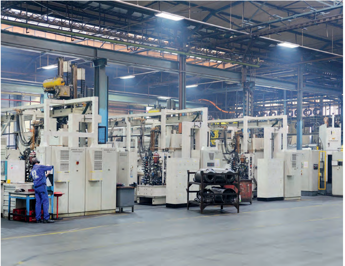
Je nach Hallengröße amortisieren sich Investitionskosten in energiesparende Leuchten bereits nach zwei bis vier Jahren (Foto: Eurolux)
