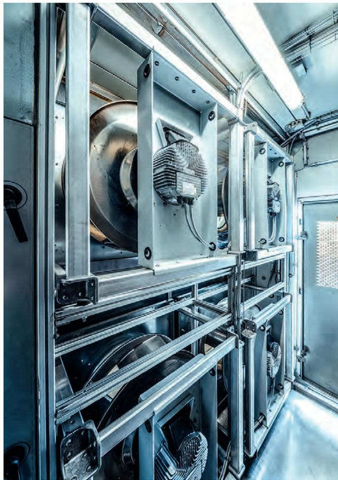
Die neue Lüftungsanlage mit insgesamt 16 RadiPac EC-Ventilatoren sorgt dafür, dass die Milchprodukte bei konstanten fünf Grad Celsius immer frisch bleiben (Foto: ebm-papst)
