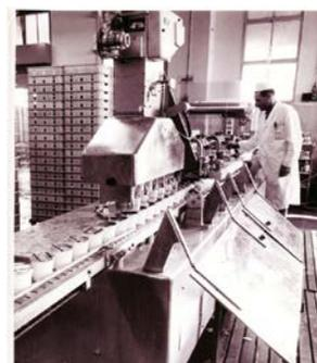
1965: Füll- & Verschließmaschine GASTI DG 25/6 für vorgefertigte Becher (Foto: GASTI)
