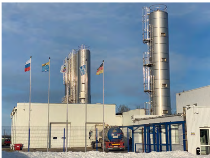
Die 2017 übernommene Käserei in Belinski wurde von Hochland umfassend saniert
