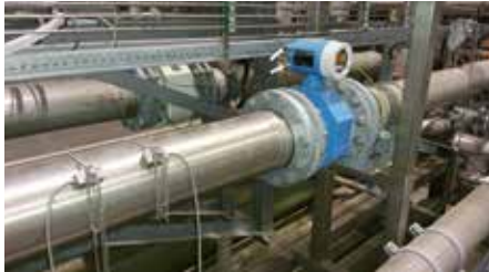
Vergleichsmessung zwischen Aufsnallsystem Clamp On und klassischem MID (Foto: FLOW-TEC)
