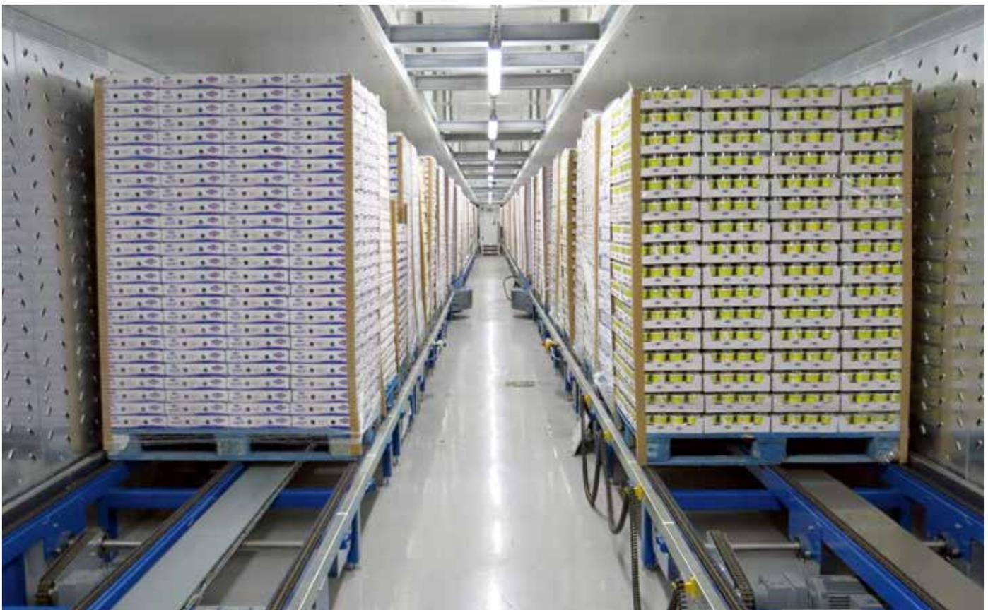
airinotec ChannelCool: Zweispuriger Kühltunnel mit Servicegang (Foto: airinotec)
