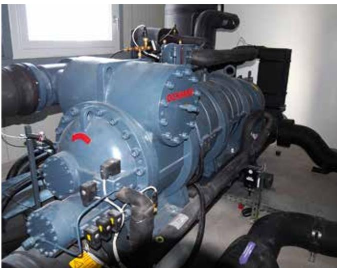
Einen Großteil der Wärmeenergie bezieht die Käserei von einem benachbarten Rechenzentrum, im Foto die Wärmepumpe (Foto: mi)
