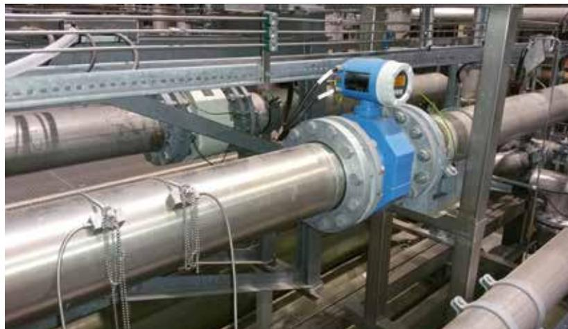
**FLOW-TEC Umweltdatenservice prüft die Genauigkeit der verbauten Durchflussmesstechnik**
