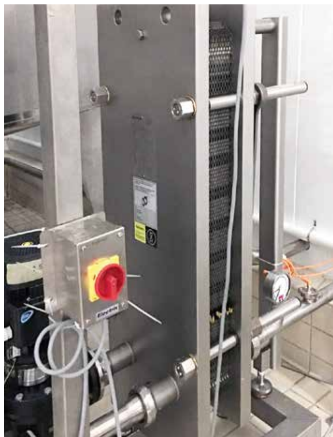
Einstufiger PWT Joghurtkühler NL 80 im Einsatz bei KRI KRI (Foto: Kelvion)
