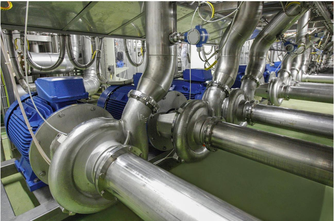
**In der ersten Umrüstungs-Phase wurden insgesamt 16 Packo-Kreiselpumpen des Typs MFP 3 mit einer Leistung von jeweils 90 kW verbaut**
