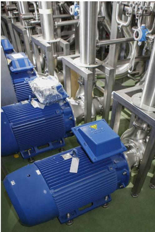
**Derzeit in der Installation sind noch leistungsstärkere MFP3-Pumpen mit 200-kW-Motoren**
