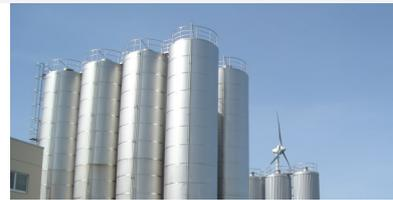
Rohmilch muss in Lagertanks unter Einhaltung der erforderlichen Kühlung und Hygieneanforderungen gelagert werden. Spätestens am Folgetag wird der hochsensible Rohstoff weiterverarbeitet. Die großen Lagertanks mit modernen Kühl- und Reinigungssystemen können mehr als 500.000 Liter Rohmilch fassen. Sie werden regelmäßig gereinigt und desinfiziert, bevor sie erneut verwendet werden. Ältere Tankanlagen konnten häufig nur ein Volumen von wenigen tausend Litern fassen.
